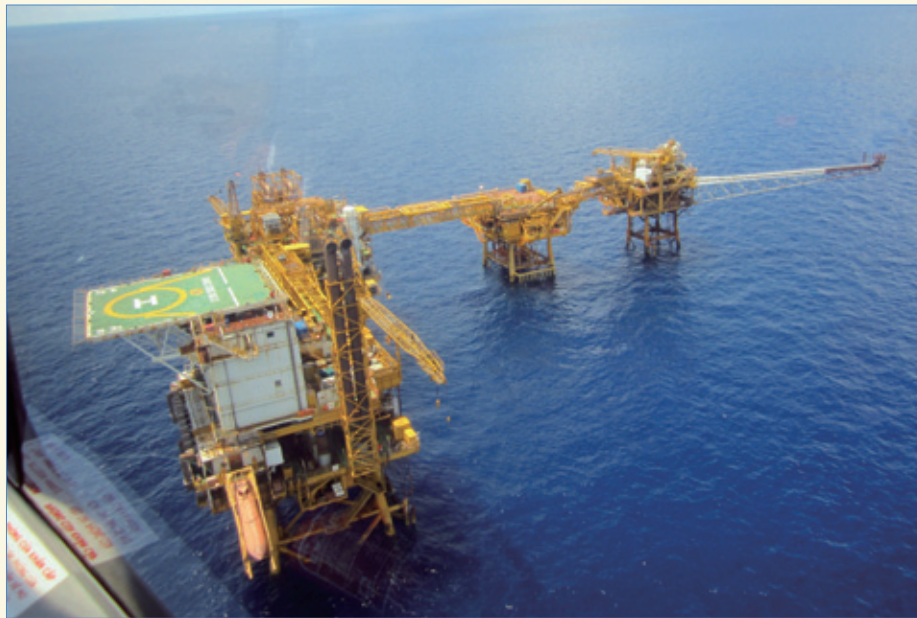
▲ヘリコプターから見渡すランドン油田中心施設。随伴ガスは海底のパイプラインを通じて陸上の発電所まで送られる
